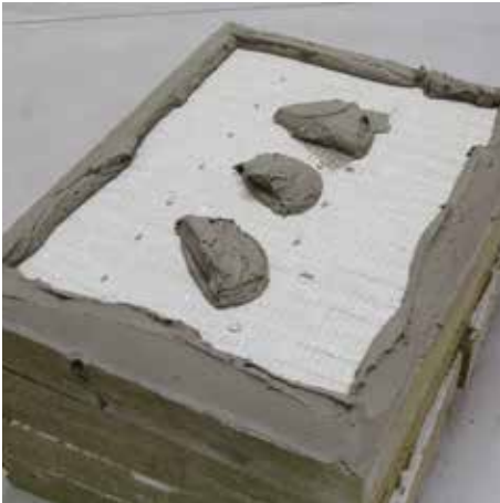
Wulst-Punkt-Verklebung (Bild 1)
