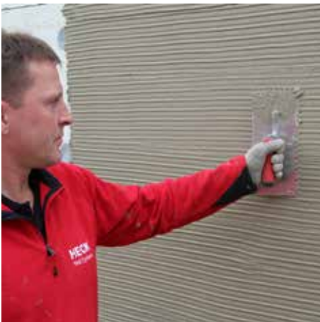
maschinelle Verklebung (Bild 3)
