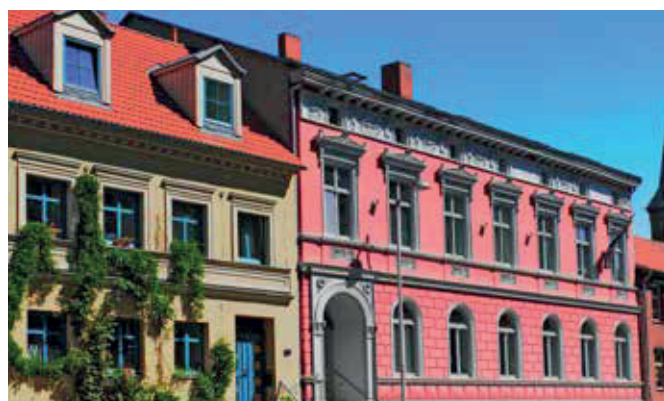
Gebäude mit Grenzbebauung
